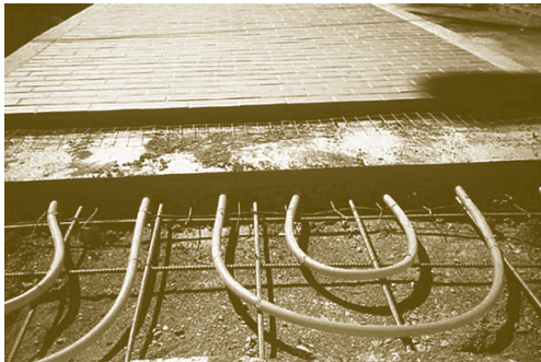
شکل ۴: نمایی از روش ذوب برف و پیشگیری از یخبندان معابر توسط انرژی زمین گرمایی [۲۰].
