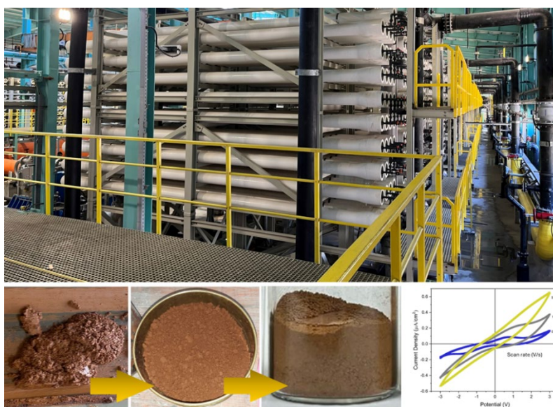
شکل ۳: نمایی از پلنت‌های شوری‌زدایی آب در خلیج فارس و مراحل خشک، پودر و قرص کردن نمونه‌های WTS به‌همراه نتایج سیکلوولتامتری از شبه‌خازن مبتنی بر آن‌ها [۵۷].
